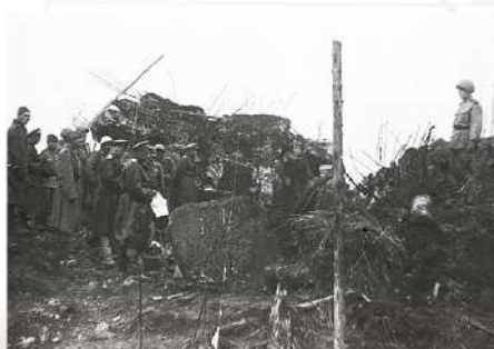
Японский ДОТ, уничтоженный советскими саперами в районе Харамитогского укрепленного района на Сахалине. Август 1945
