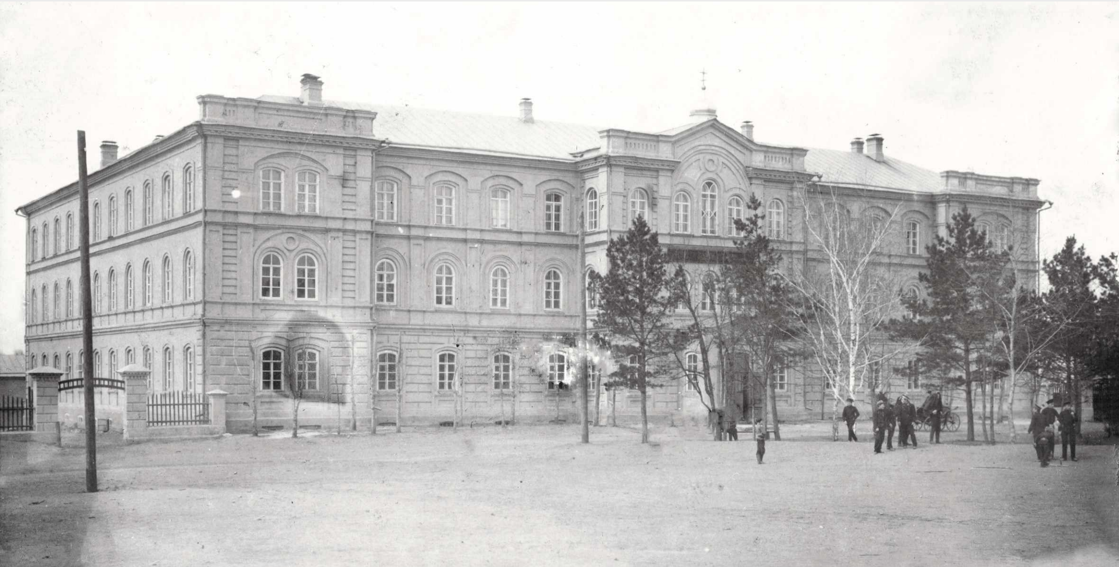
Здание ремесленного училища. г. Благовещенск, 1920-е гг.
