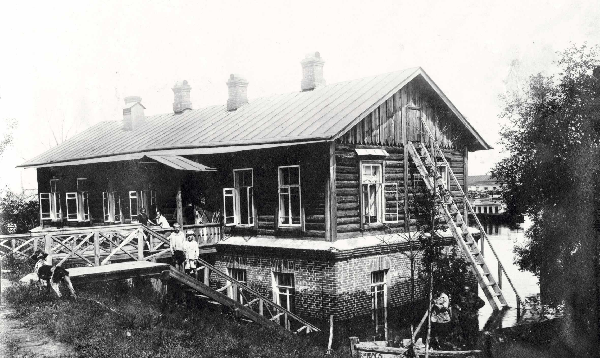
Здание конторы амурского водного управления. г. Благовещенск, 1920-е гг.
